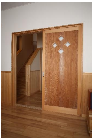
外した天井板を利用した引戸
